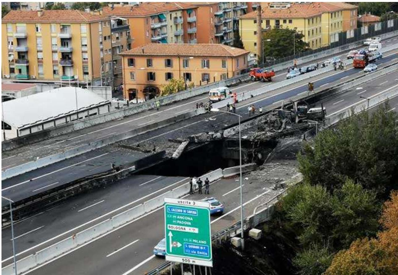
Fig. 43 – cedimento delle travi e parte dell'impalcato del ponte autostradale (Fonte V, Vanzini)
